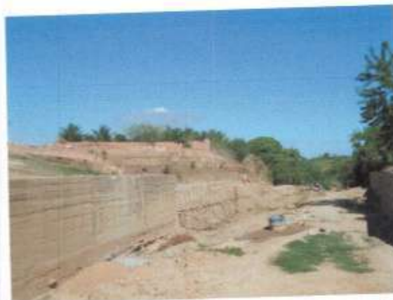
Foto 69: Obra de muro de contenção de encosta do Riacho Tabocas.
