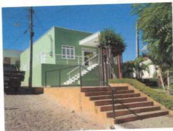
Foto 47: Posto de Saúde localizado à Rua Princesa Izabel, no Bairro Centro.
