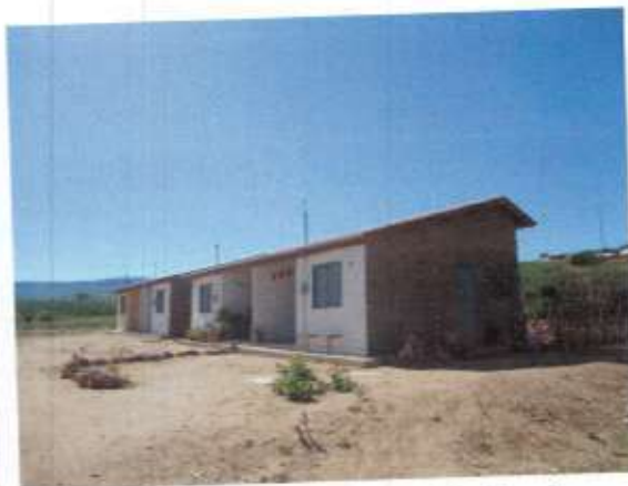
Foto 150: Seis unidades habitacionais construídas no bairro Entre Rios.
