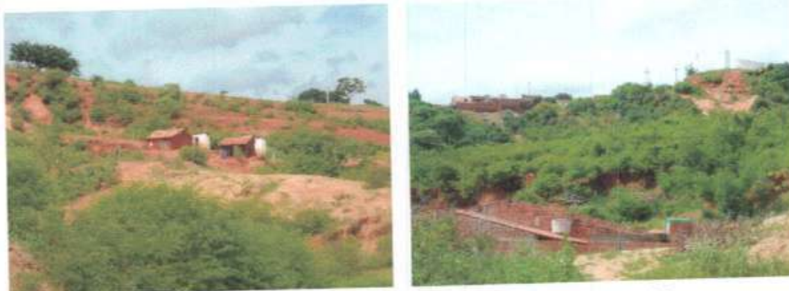
Fotos 70 e 71: Ocupações em área vulnerável na encosta do Cemitério.
