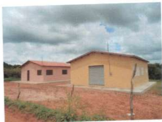
Foto 12: Edificações recentemente implantadas da "Casa do Mel" e "Casa da Polpa de Fruta" no Sítio Abreus.
