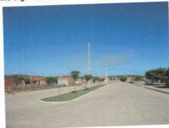
Foto 38: Vista da Av. Manoel Pedro de Lima, no Bairro Sol Nascente, onde o traçado viário é ortogonal e as ruas são largas.
