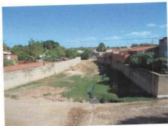
Foto 68: Muros de contenção das encostas do Riacho Oitis.
