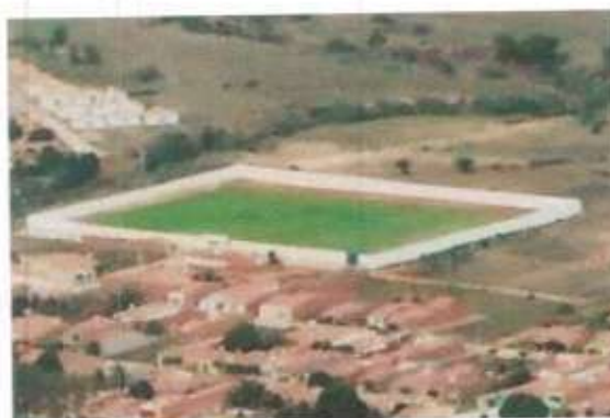
Foto 157: Estádio Municipal de Porteiras após a finalização da primeira etapa das obras.
