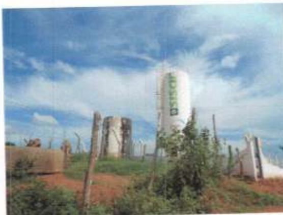
Foto 32: Poço tubular no Sítio Moreira, implantado pelo Sisar.
