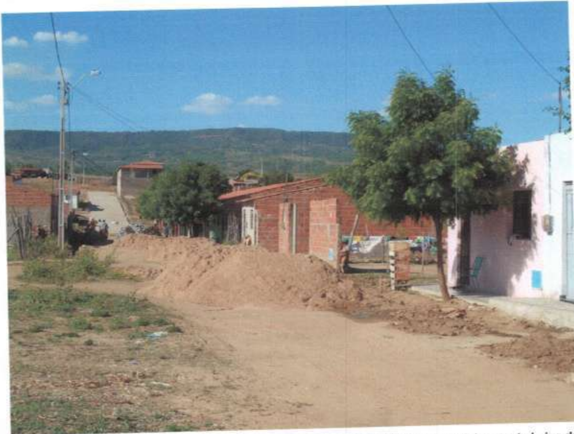
Foto 80: Vista da R. Tarso Pereira Dantas, que apresenta acúmulo de água pluvial na parte baixa de seu perfil.
