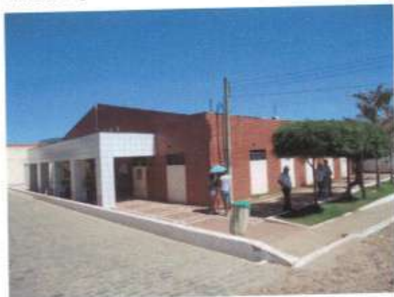
Foto 53: Prefeitura Municipal, localizada à Rua Mestre Zuca, no Bairro Centro, apresentando-se em bom estado de conservação.
