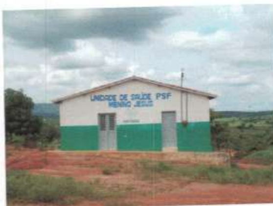
Foto 19: Unidade de Saúde no Sítio Abreus em bom estado de conservação.
