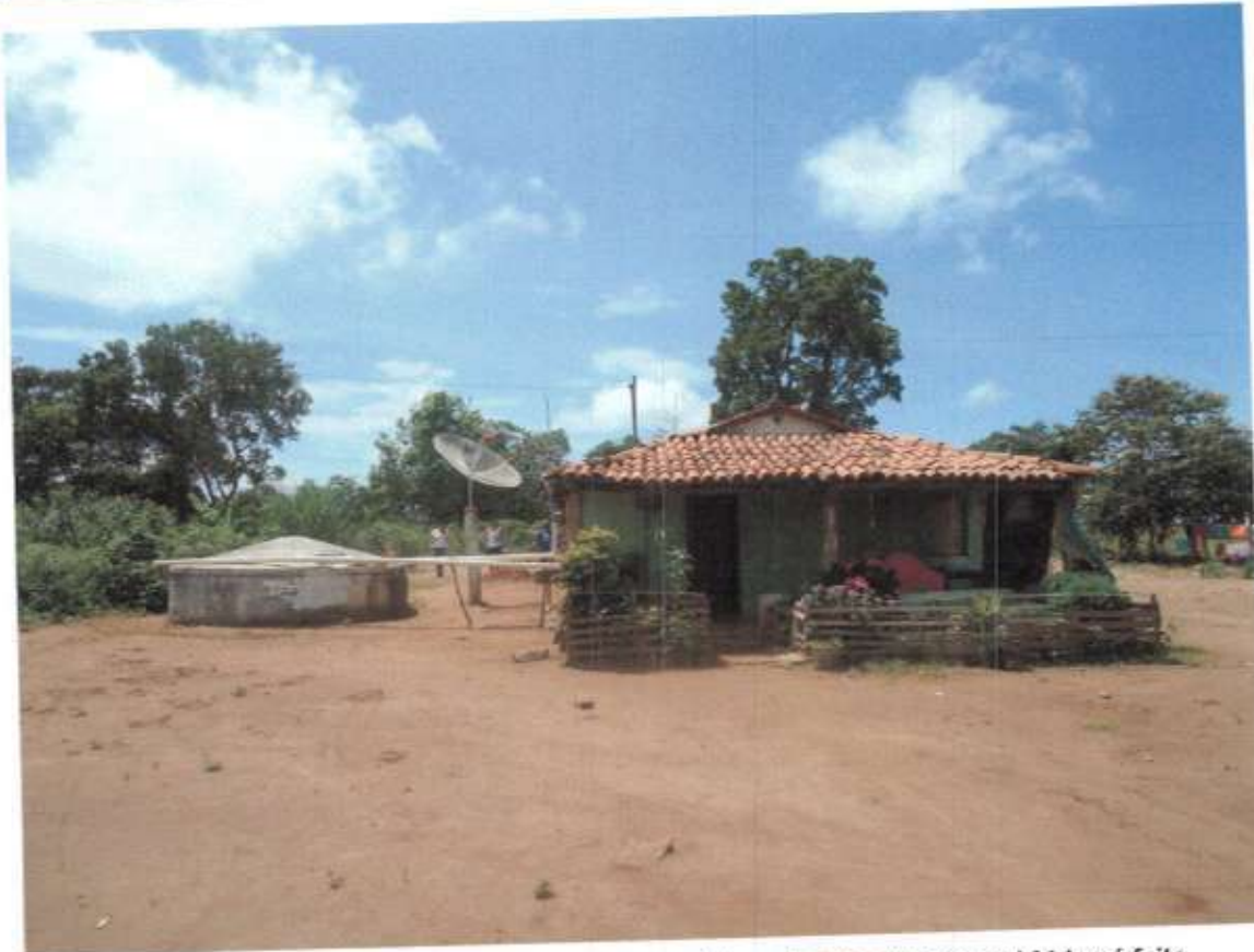
Foto 33: Edificação residencial no Sítio Vassourinha cujo abastecimento hídrico é feito exclusivamente por armazenamento de água pluvial através de cisterna (à esquerda).
