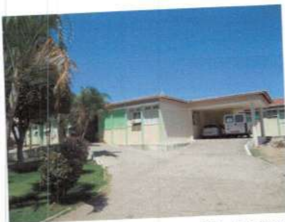
Foto 132: Edificação da Unidade Mista de Saúde do município de Porteiras.
