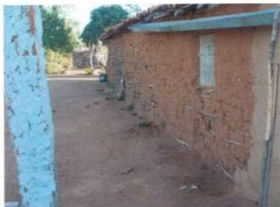
Foto 161: Residência na comunidade dos Souza, casa de taipa.
