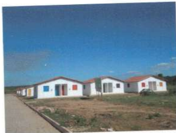
Foto 63: Conjunto Habitacional de Interesse Social recém construído no Bairro Sol Nascente.
