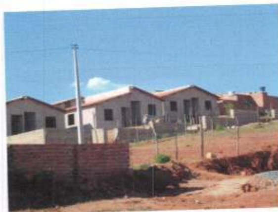
Foto 64: Conjunto Habitacional de Interesse Social em construção no Bairro José Aristarco Cardoso.
