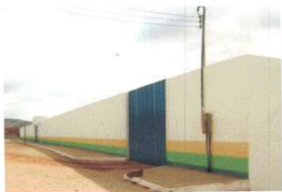
Foto 156: Muro do Estádio Municipal de Porteiras após a conclusão da primeira etapa da obra de construção do Estádio.
