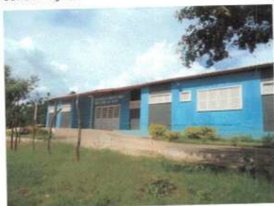
Foto 18: Escola de ensino fundamental no Sítio Moreira em bom estado de conservação.
