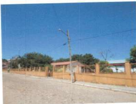
Foto 50: Escola Estadual Aristarco Cardoso, localizada à Rua Expedito Araújo Santana, no Bairro Centro.
