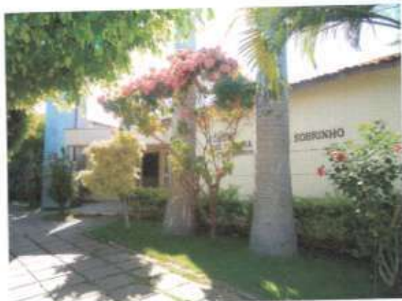
Foto 51: Fórum, localizado à Rua Prefeito A. Denguinho Santana, no Bairro José Aristarco Cardoso, apresentando-se em bom estado de conservação.
